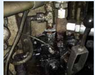
Durch ausgetretene Hydraulikflüssigkeit verbrannte Ventile
