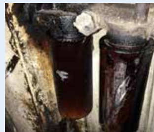
Die Flüssigkeit im Tank wurde so heiß, dass die Farbe am Tankboden schmolz und abblätterte
